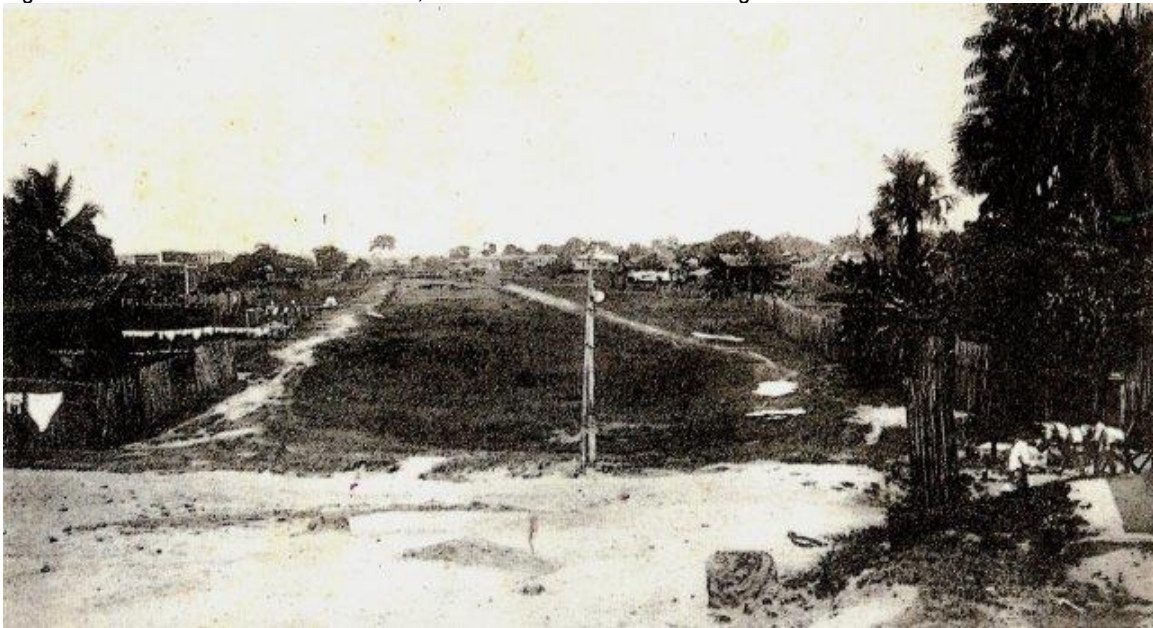
Figura 18: Avenida Doca de Souza Franco, antes das obras de macrodrenagem
